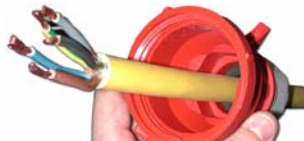
Kuva 3: Kumikaapeli työnnetään Multi-Gripin läpi liittintilaan.
