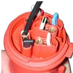
Kuva 7: Kytkentä on suoritettu eikä jälkikiristyksiä tarvita.
